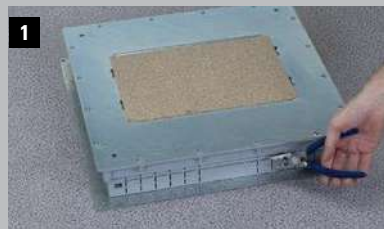
1 Прорезать входы для кабель-канала
