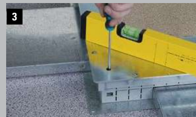
3 Отрегулировать с помощью винтов
