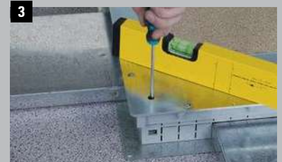
3 Отрегулировать с помощью винтов
