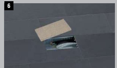
6 Снять защитную заглушку
