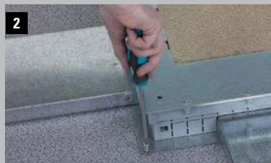
2 Вставить кабель-каналы и привинтить к полу
