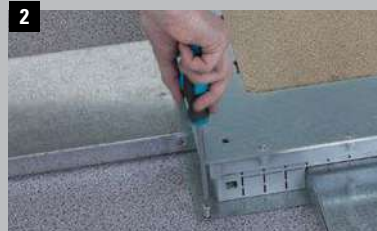
2 Вставить кабель-каналы и привинтить к полу
