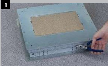
1 Прорезать входы для кабель-канала
